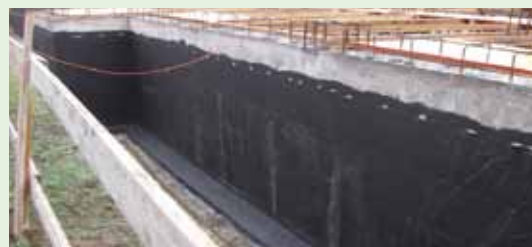
Proteggere l'impermeabilizzazione con PROTEFON TEX o pannelli in PSE
